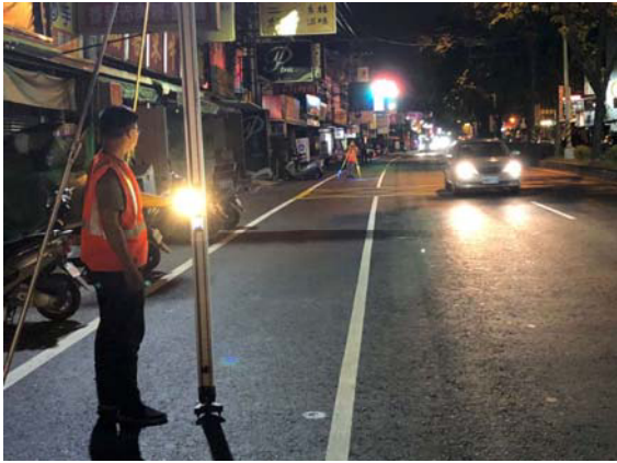
圖 3-19 市區道路作業
