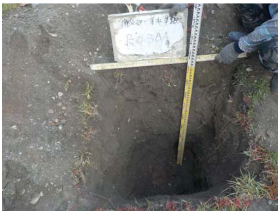
圖 2-11 埋設點位挖掘
