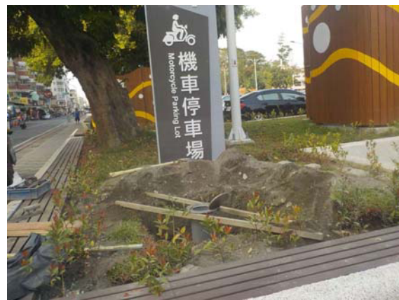
圖 2-12 第一次混凝土施工
