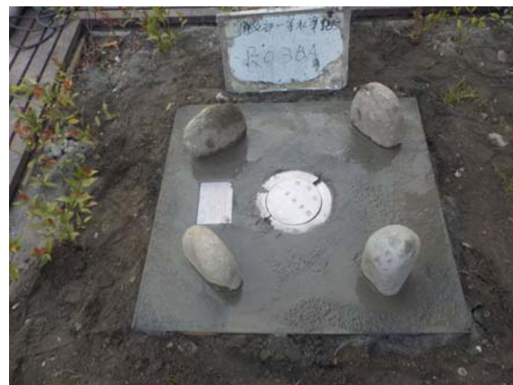
圖 2-14 第二次混凝土施工
