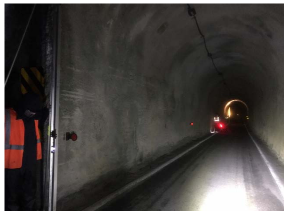
圖 3-24 山區隧道作業
