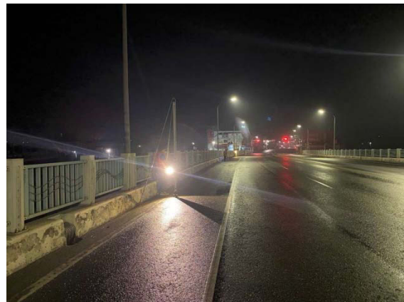
圖 3-22 跨河橋樑作業
