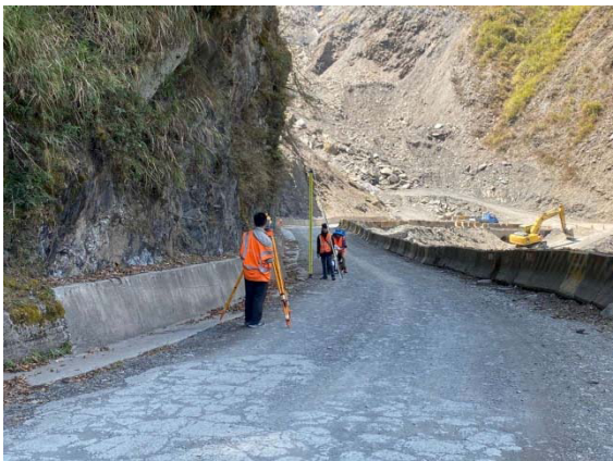
圖 3-21 道路施工區域作業
