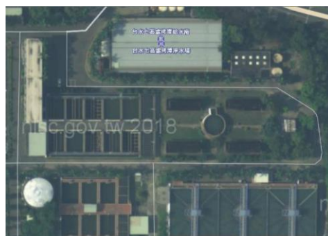
(b) 台水七區處拷潭給水廠
