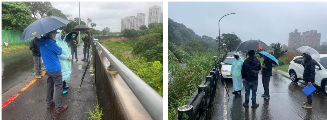
圖 4.2-13 溢堤線驗收作業中照片
