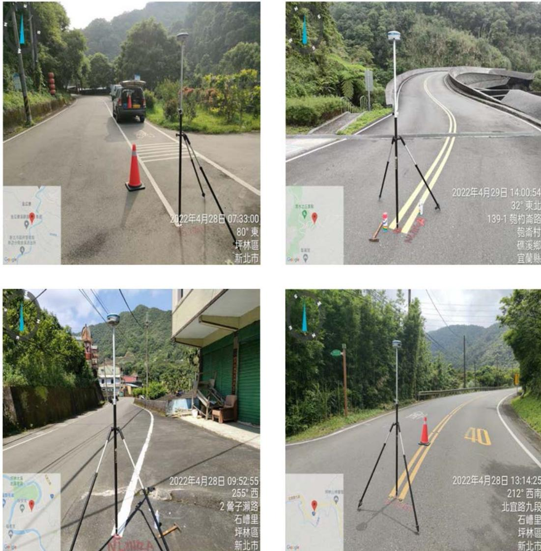
圖 2-6 航測控制與檢核點測量現場照片圖
