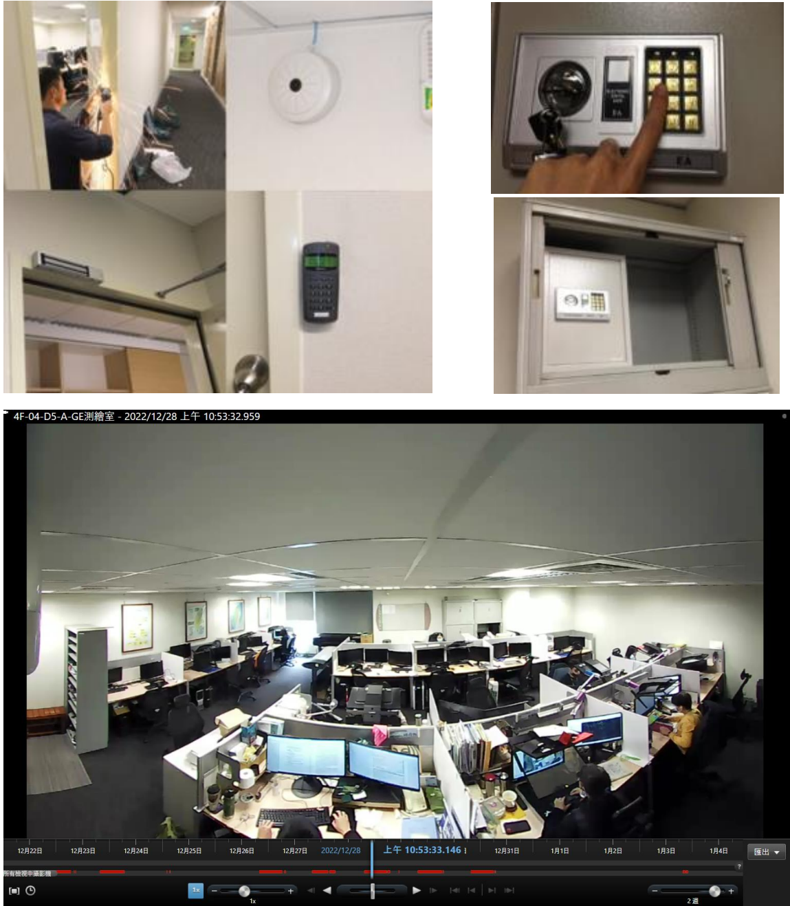
圖 3.21-1 設置機密資料管制室
