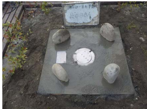
圖 2-14 第二次混凝土施工
