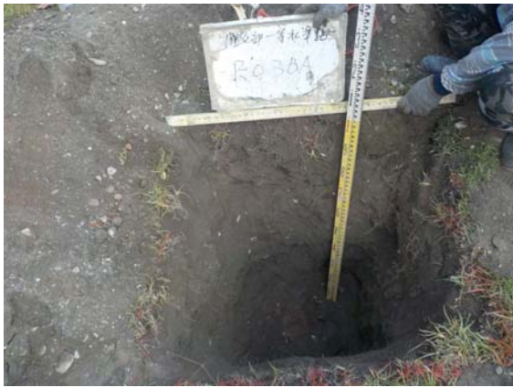
圖 2-11 埋設點位挖掘
