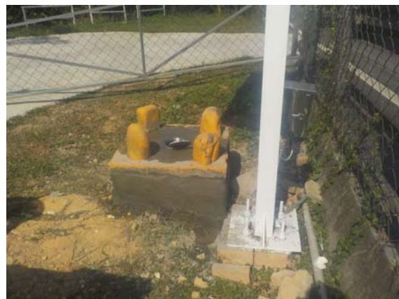
圖 2-17 基座補強作業（左圖為補強前；右圖為補強後）
