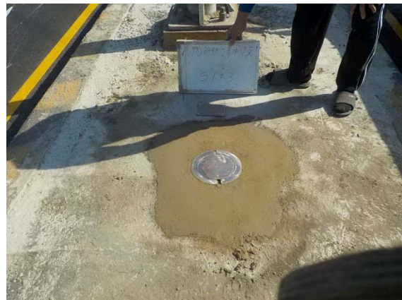
圖 2-16 不銹鋼蓋提升作業（左圖為提升前；右圖為提升後）
