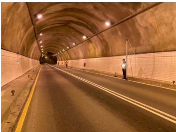
圖 3-23 公路長隧道作業
