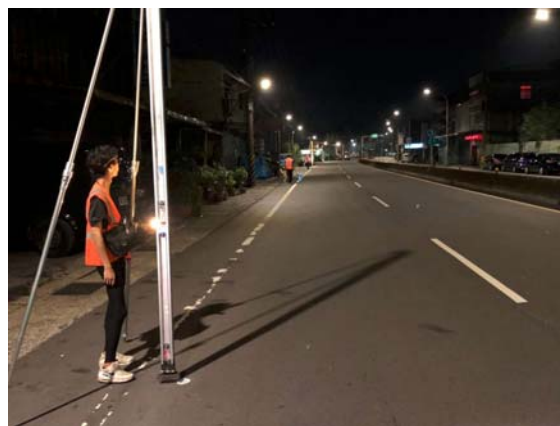
圖 3-15 儀器與二水準尺呈一直線
