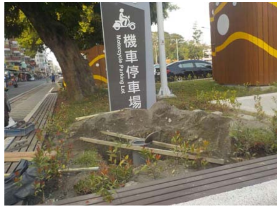
圖 2-12 第一次混凝土施工
