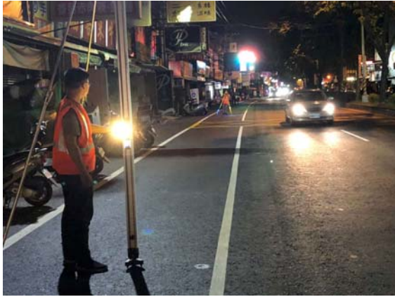
圖 3-19 市區道路作業
