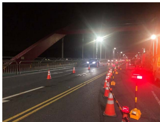
圖 3-2 水準路線遇工程進行（以關渡大橋為例，原為 109 年 8 月施測關渡節點附近測線，因關渡大橋施工，除縮減車道外，施工中的震動亦造成水準測量無法作業，故相關測段延後至 110 年 3 月施測）
