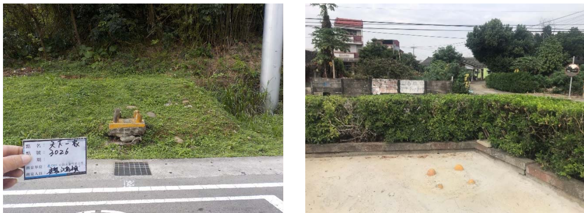
圖 2-3 需基座補強之一等水準點（左圖點位基礎裸露，右圖點位遭水泥覆蓋）
