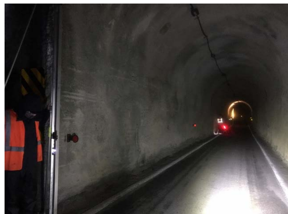
圖 3-24 山區隧道作業
