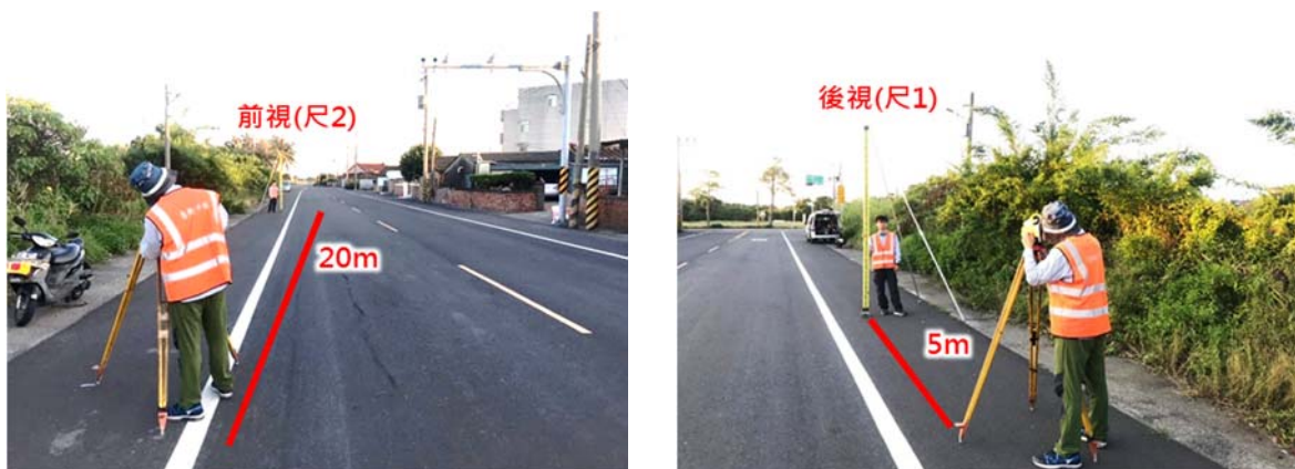
圖 3-5 水準儀視準軸校準情形
