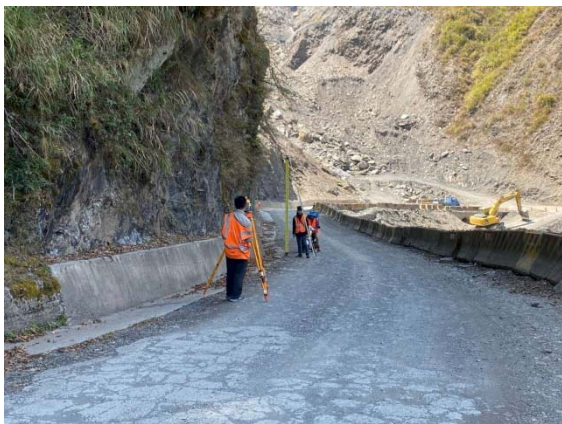
圖 3-21 道路施工區域作業
