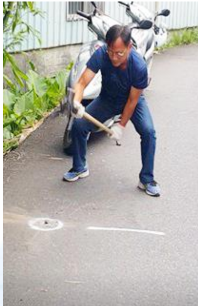
圖 3 -12 辦理圖根點布設情形
