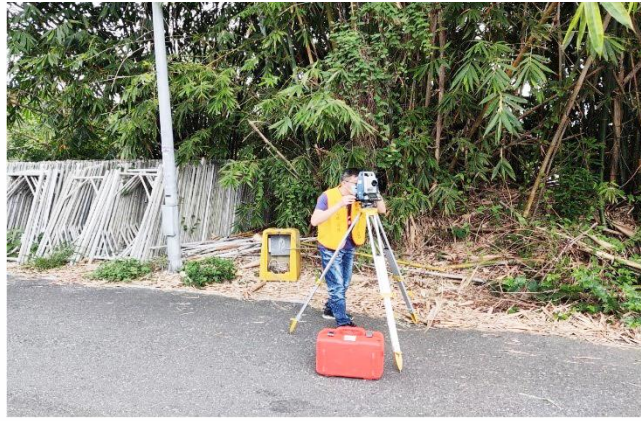
圖 3 -14 辦理現況測量作業情形
