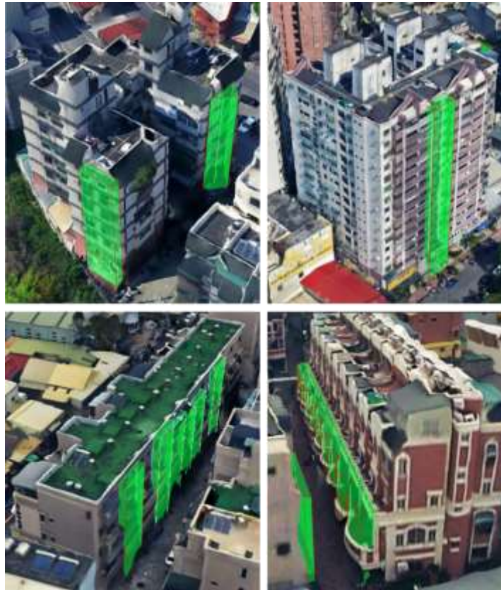
圖 4-67 住宅區建物樓高異常態樣(鄰近高樓雨遮)
