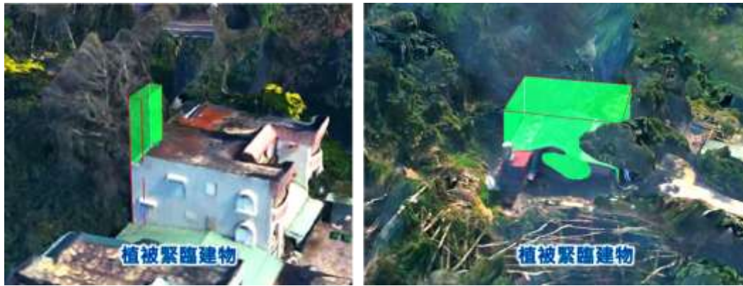
圖 4-71 農業區建物樓高異常態樣(植被緊鄰建物)
