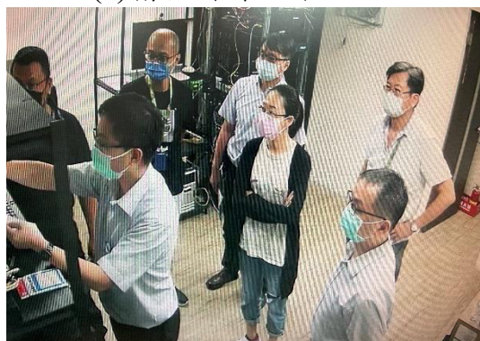
(c)準線智慧科技股份有限公司機房
