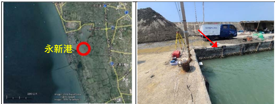
圖 3-8、永新港臨時潮位站設置位置
