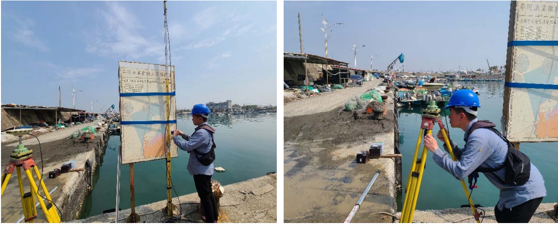
圖 3-7、水深測量GPS陸上固定站架設照片
