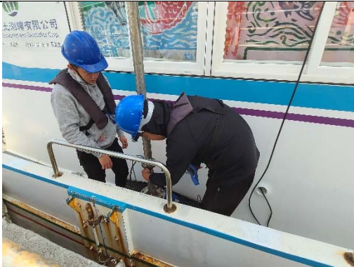
音鼓架設照片
