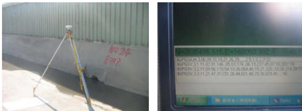
圖 5-20 DGPS 定位檢測作業情形
