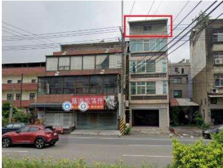
圖3-41 樓層增建現地狀況
