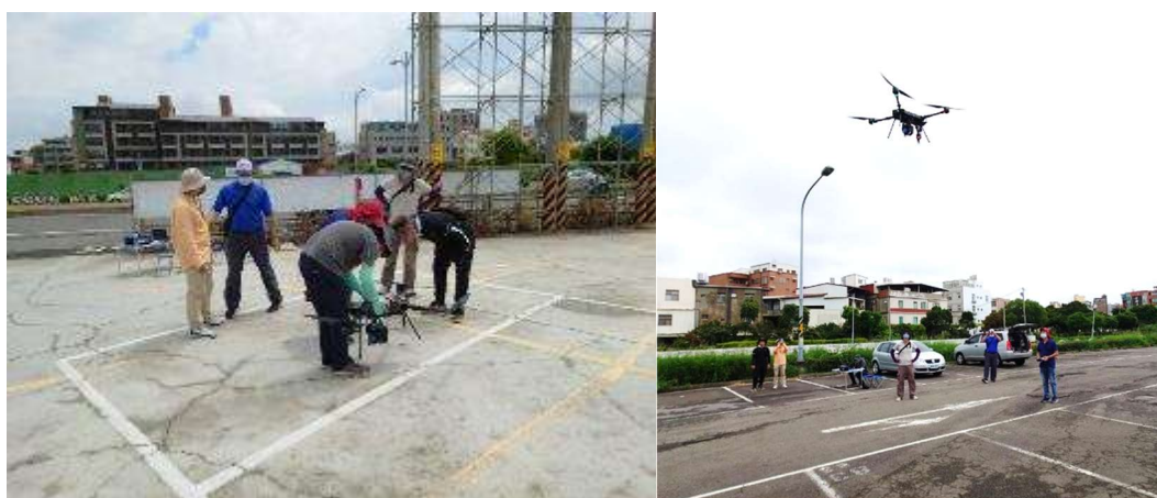
圖3-13 設備檢查及航拍作業情形
