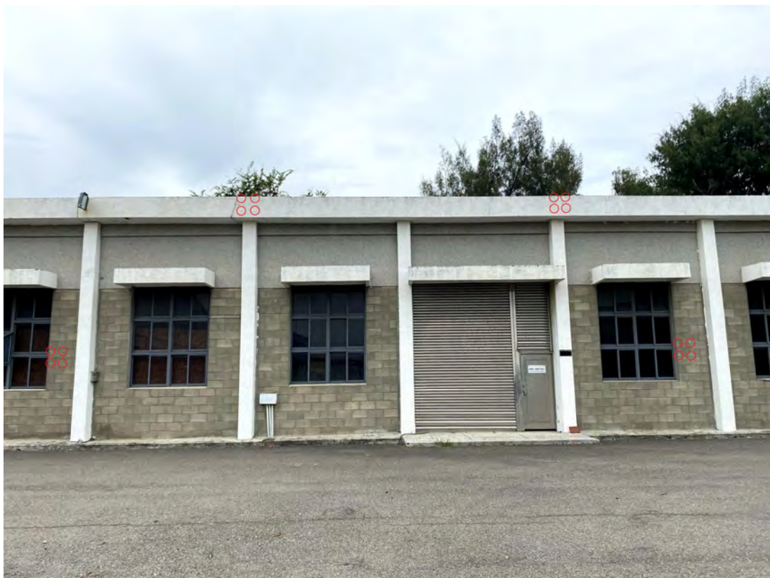
圖 3-50 牆面磁鐵施工建置完成（東側建物）
