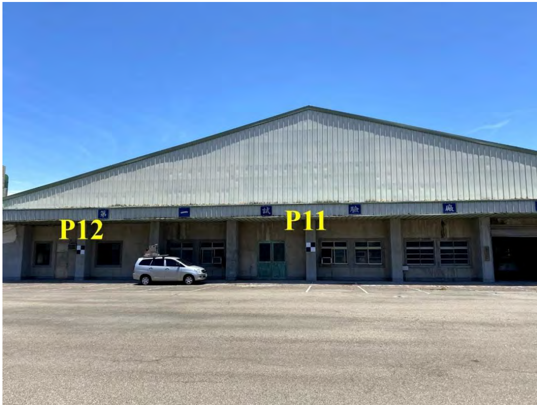
圖 3-55 牆面校正標安裝完成（北側建物）
