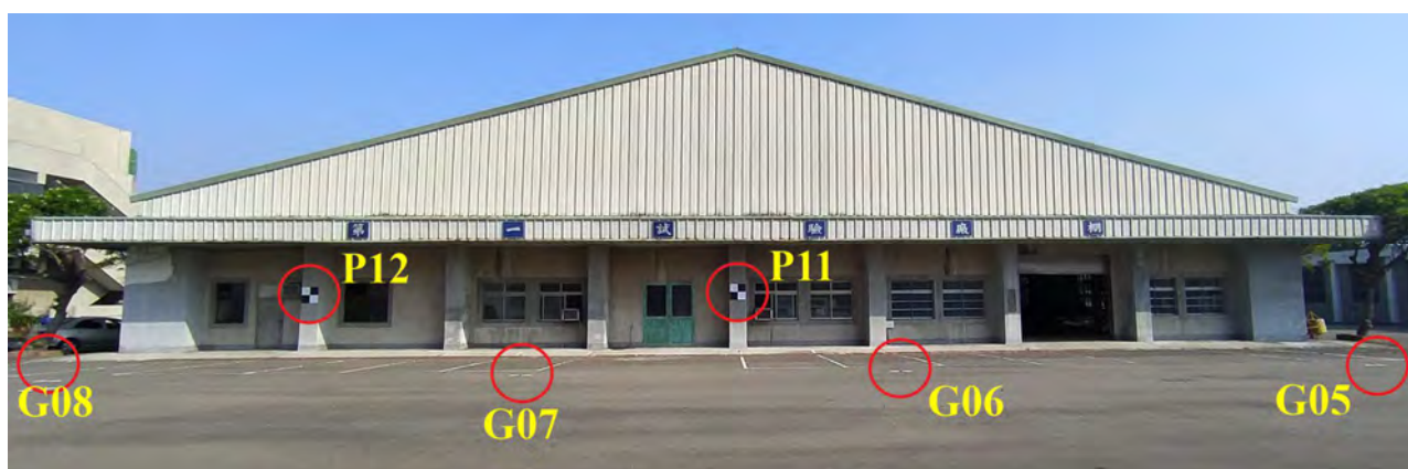
圖 3-9 校正標安裝位置示意圖-3
