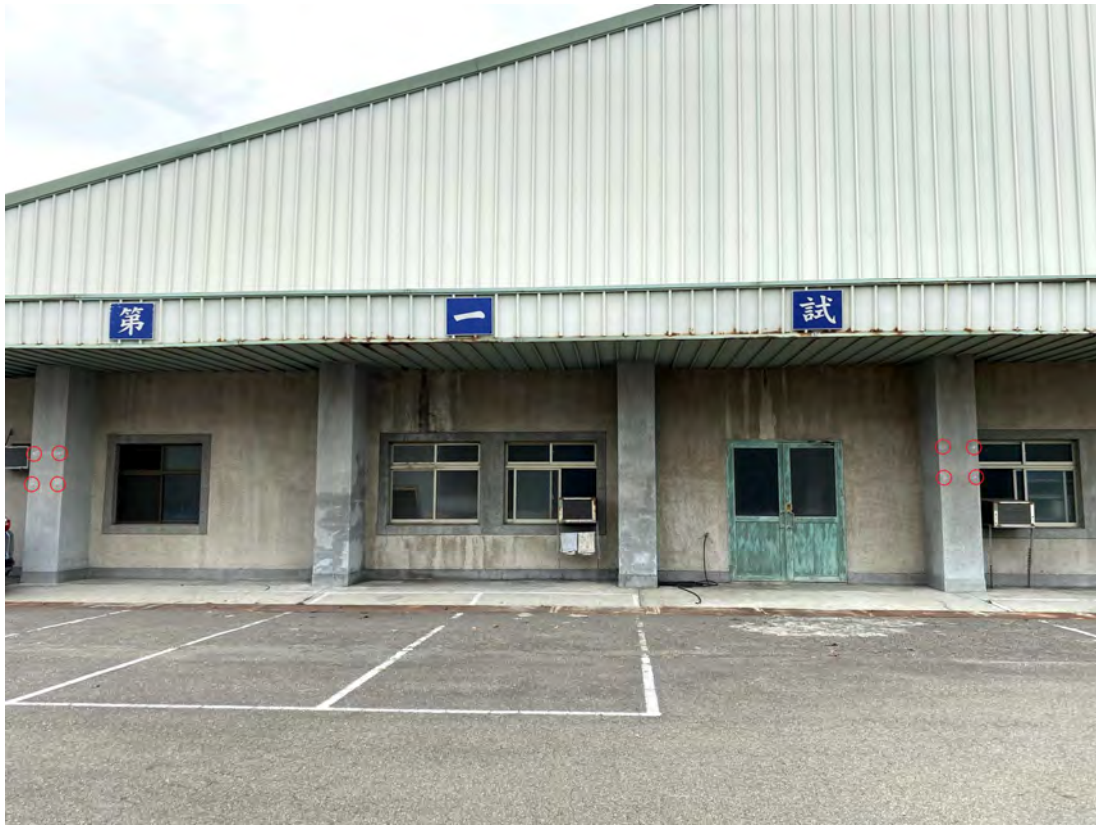
圖 3-51 牆面磁鐵施工建置完成（北側建物）
