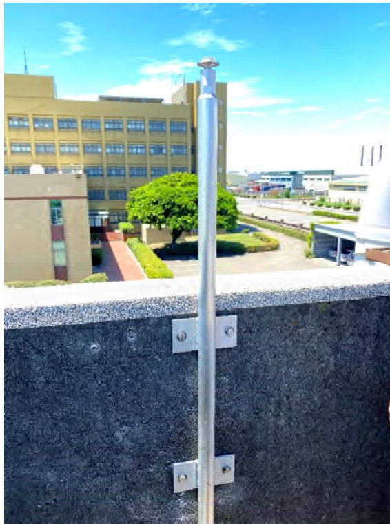
圖 3-65 GNSS 靜態基站施工建置完成
