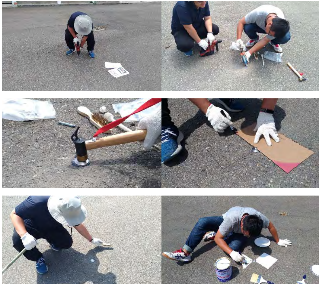
圖 3-57 地面標施工過程（鑽孔、AB 膠、埋鋼標、清潔、繪製）
