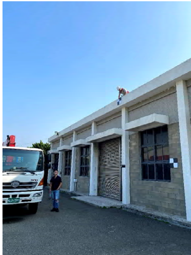
圖 4-19 校正標坐標參考值量測作業－安裝牆上磁吸式校正標
