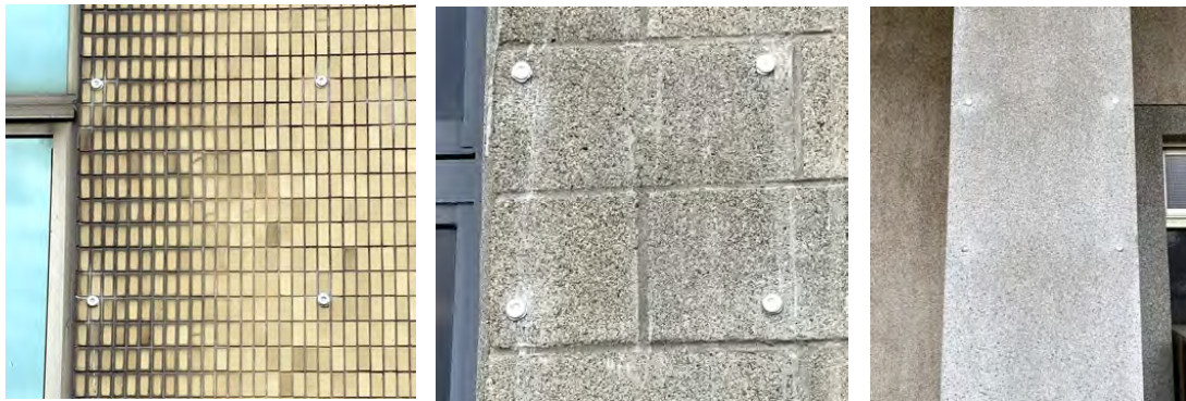
圖 3-52 牆面磁鐵施工建置完成—細部檢視
