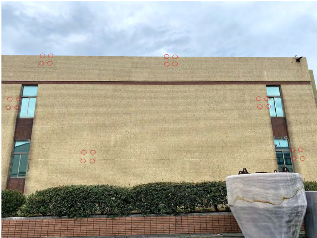
圖 3-49 牆面磁鐵施工建置完成（南側建物）
