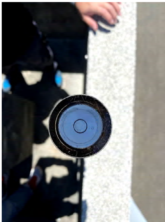
圖 3-66 GNSS 靜態基站施工建置完成—水平儀確認
