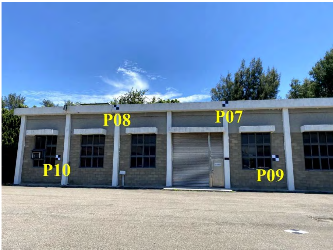
圖 3-54 牆面校正標安裝完成（東側建物）
