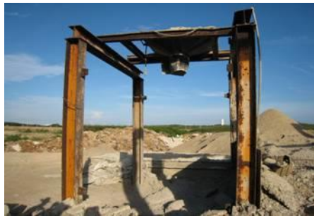
土石相關設施（戶外簡易式）
