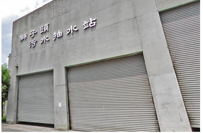
污水抽水站→060600 環保設施
