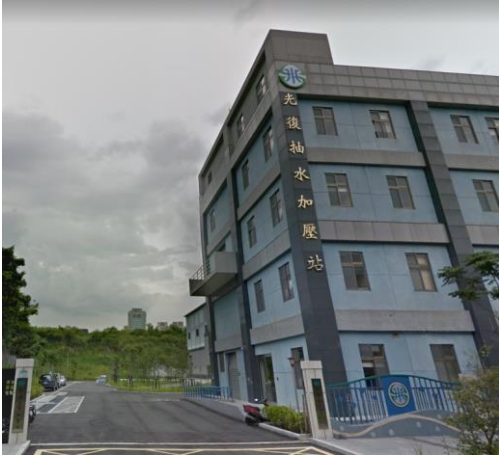
自來水抽水加壓站→060504 自來水
