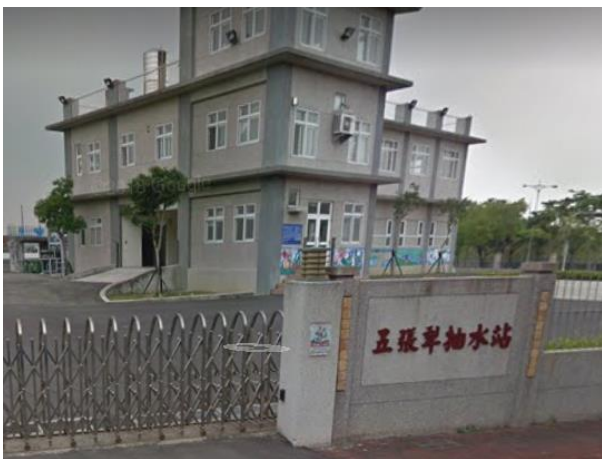
五張犁抽水站→040403 抽水站
