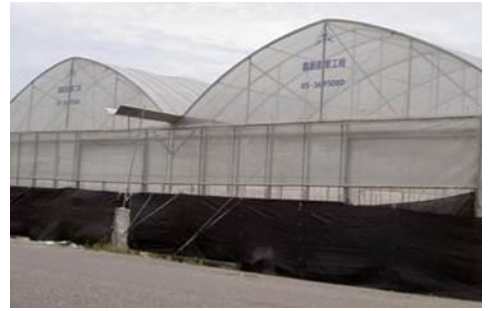
防颱溫室外觀結構
