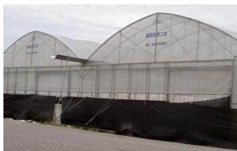
防颱溫室外觀結構
