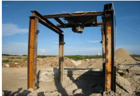
土石相關設施(戶外簡易式)
