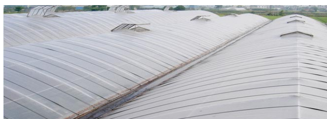
防颱溫室屋頂增設天窗系統
