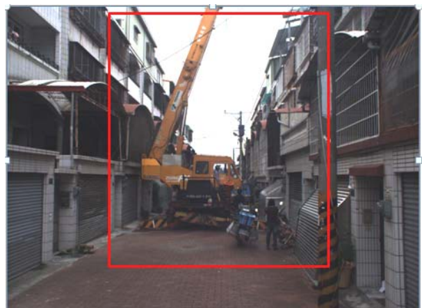
(b)巷道施工
