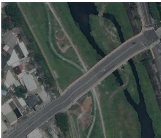
圖 5.3-10 橋梁變形錯誤修正前
