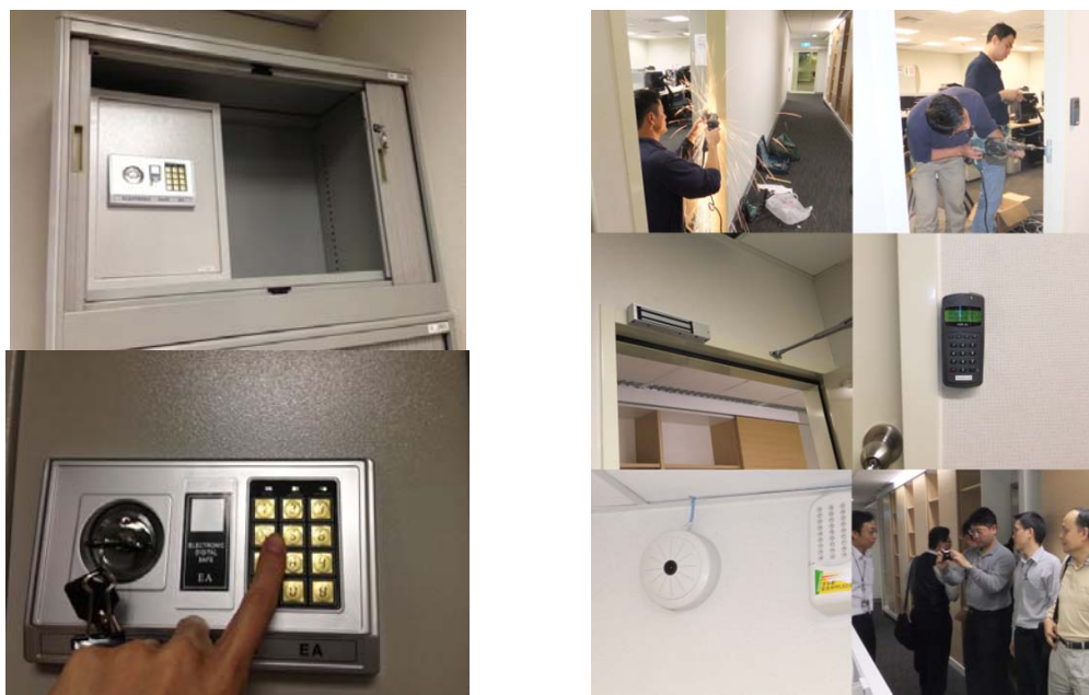
圖 3.14-1 機密管制室建置
