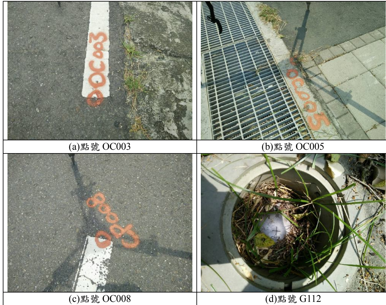
圖 3-5-2-4 第 2 作業區控制測量成果抽驗點位照片
