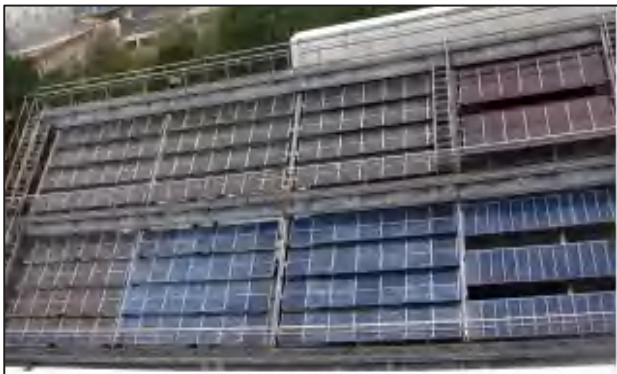
圖 3-2-10. 太陽能光電實驗室
