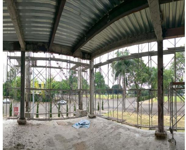
圖 4-4-8. 實尺寸鋼構實驗屋之 H 型鋼角、邊柱照片
