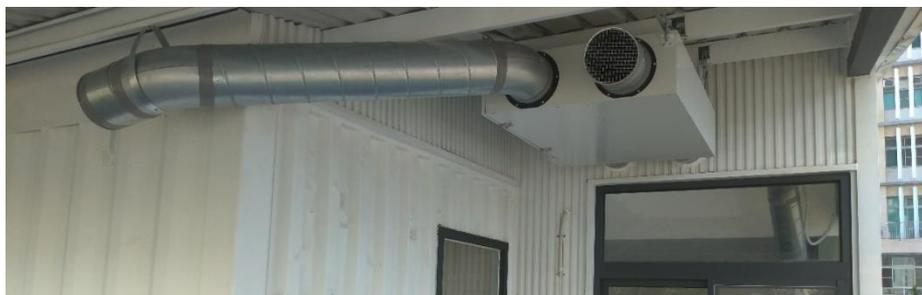
圖 4-22 風管型全熱回收換氣機於室外側之現場圖
