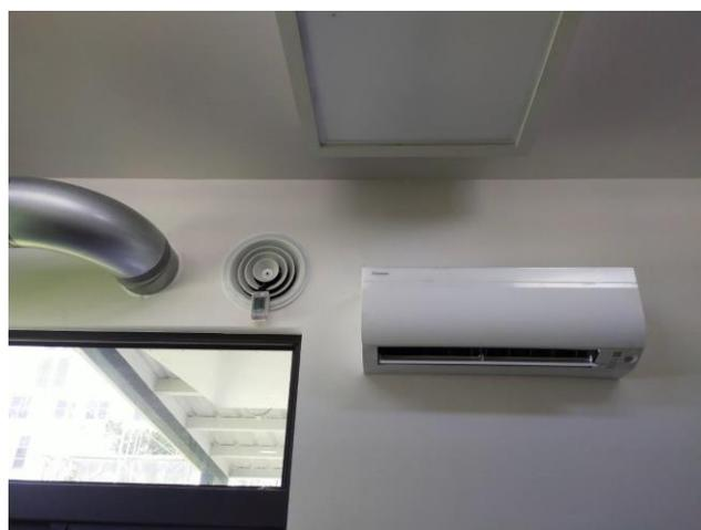
圖 4-23 風管型全熱回收換氣機於室內側之現場圖
