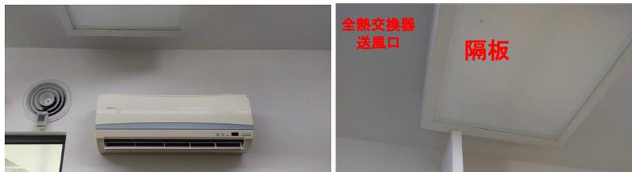
圖 4-33 全熱交換室內供風口與空調機之間無隔板(左)影響空調機回風溫度
