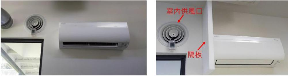
圖 2-29 全熱交換室內供風口與空調機之間無隔板(左)與有隔板(右)
