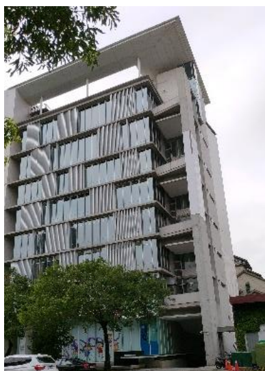
圖 1-3.建築物外觀之格柵式構造及遮陽板案例
