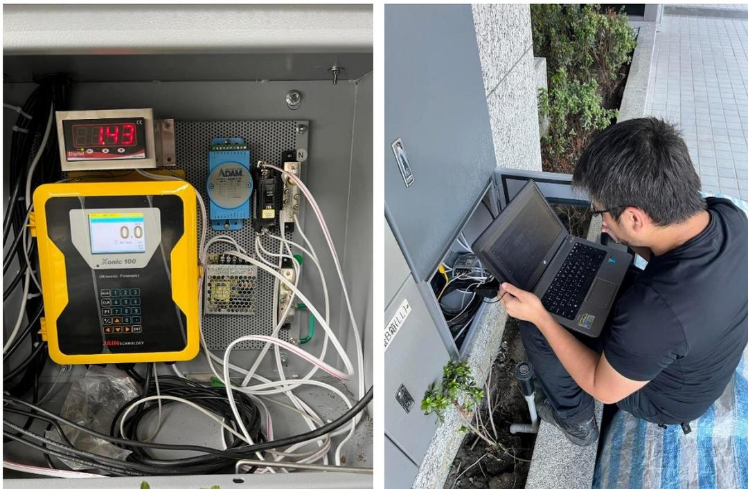
圖 2-29 台北市信義區某公宅興建案 E 標滯洪設施 C 池之智慧監控系統控制箱現場裝設成果與設備調校
