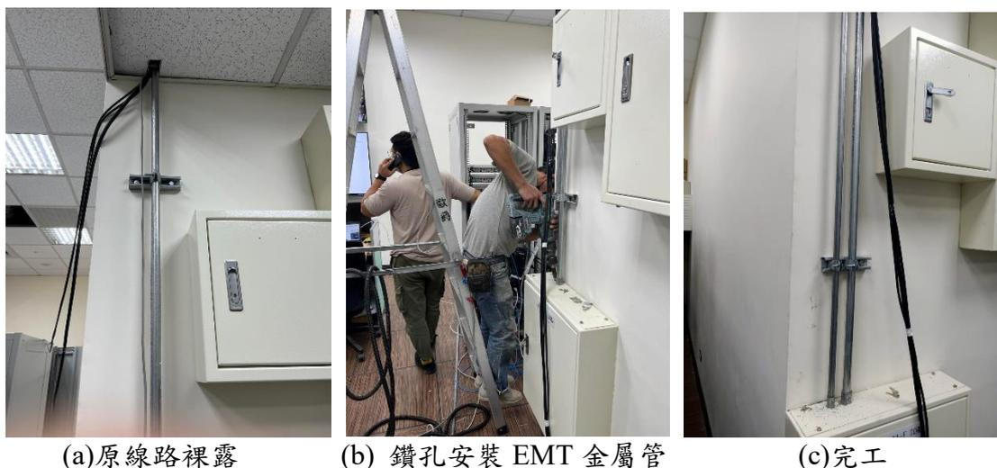
圖 3-6 台北市信義區某公宅興建案 E 標滯洪設施 C 池之中央控制中心 EMT 金屬管配置圖
