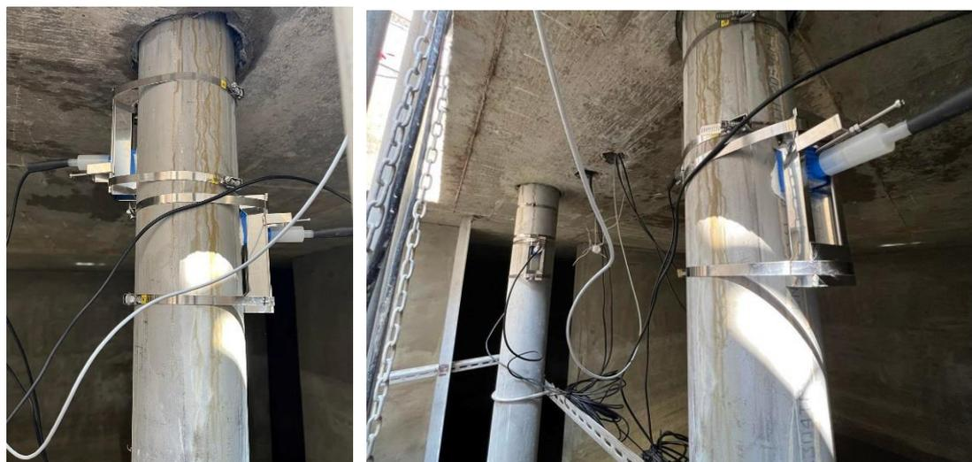
圖 2-19 夾管式超音波流量計(固定型)流量計之管外夾監測設備現場架設成果圖
