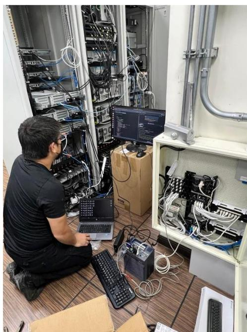
圖 2-23 MIC-7700 無風扇工業電腦設備架設與系統設定現場圖
