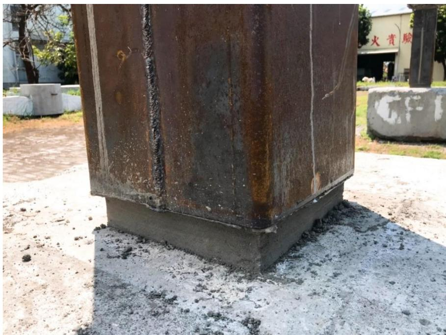
圖 4-12 柱身底部拆模
