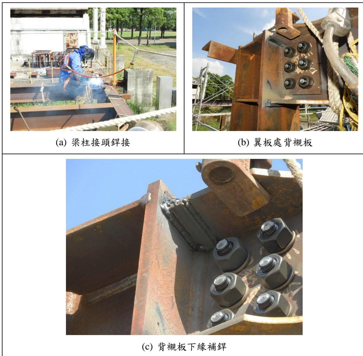
圖 5-15 鋼構實驗屋現場銲接
