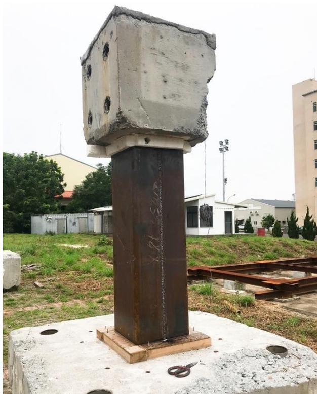
圖 4-10 柱身頂部裝設臨時模板
