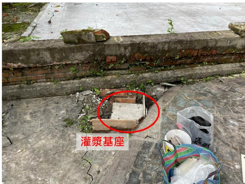
圖3-9 以灌漿方式製作穩固基座
