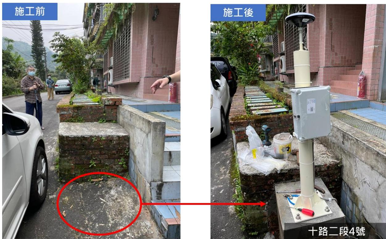
圖3-11 GNSS 測站設備安裝前、後現場照片(TTL202 固定站)
