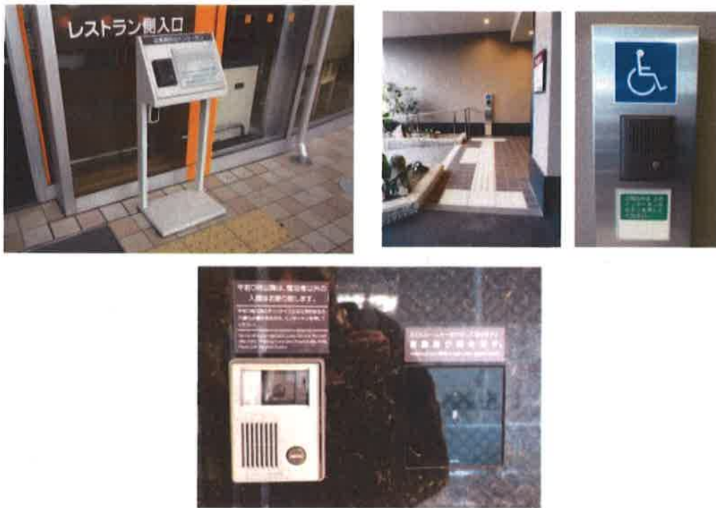
圖4-7 引導顯示器、訊息傳輸設備
