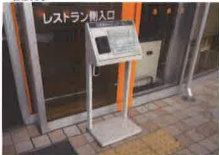
・出入口に設けられた従業員呼出しインターホン (手前に点状ブロックを3枚敷設)
