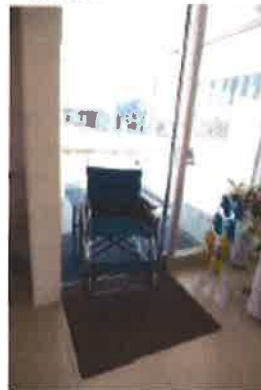
・出入口の前後に高低差のない自動式引き戸(出入口の有効幅員: 86cm)
