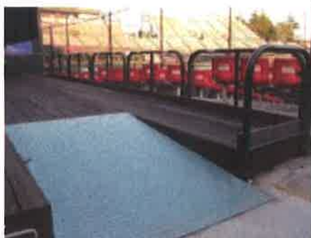
・改修により、内野席に設けられた車椅子使用者用観覧席（サイトライン確保のため床面を嵩上げしている）
