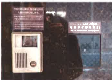
・出入口に設けられたカメラ付きインターホン(点 字併記つき)
