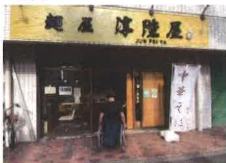
・手動式引き戸（有効幅員110cm）が設けられた出入口
