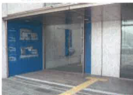
・自動式引き戸の出入口 (視覚障害者誘導用ブロック等は出入口の手前まで敷設)
