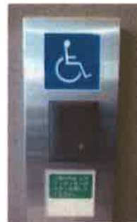
・出入口に設けられた従業員呼出しインターホン (墨字と点字が併記されている。)
