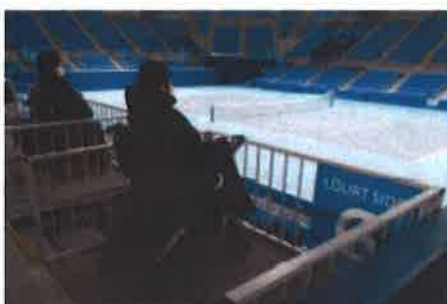
・改修により、屋内テニスコートの観覧席に設けられた車椅子使用者用観覧席（客席2段分のスペースを使って改修を実施）
