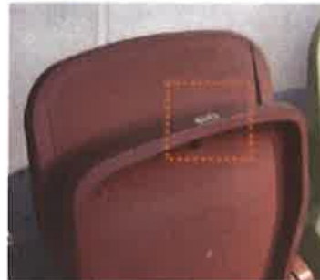
・視認性・触りやすさの観点から、座面先端部に設けられた座席の点字プレート
