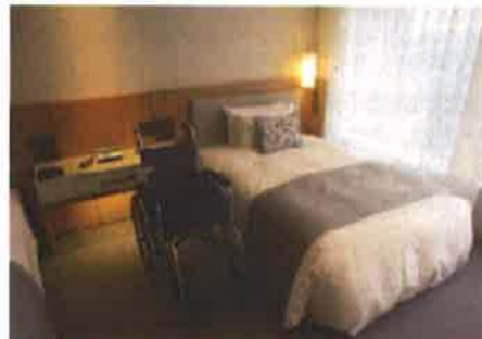
・車椅子使用者がベッドに移乗できるように設けられたベッド側面のスペース
