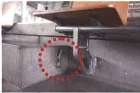
觀眾席的下方設有電磁感應線圈系統的助聽器天線電纜接線端子
