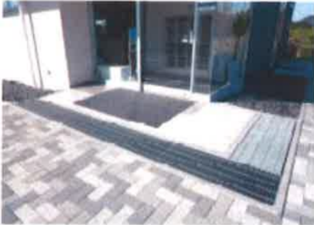
・庇の下の雨水処理のために設けた排水溝と、戸の前後の高低差を解消した自動式引き戸
