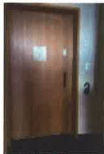
・戸の取っ手側の接近スペースが設けられた、引き戸形式の客室出入口
