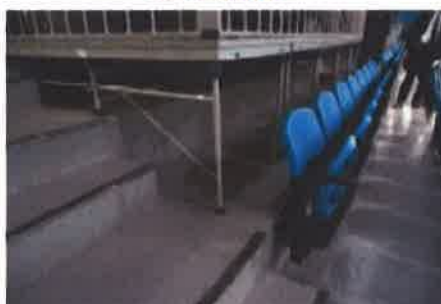
・改修により、屋内テニスコートの観覧席に設けられた車椅子使用者用観覧席（客席2段分のスペースを使って改修を実施）
