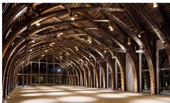
圖1.1 武重義之竹構造大跨距建築 (取自 <https://www.vtnarchitects.net/>)
