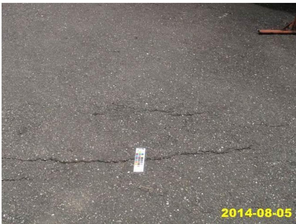
3. 社區基地西側之崗亭圍牆，因土壤下陷已有開裂現象，建請社區即早維修；該處附近之路面已經加鋪封補，仍建請社區持續觀測沉陷情形。
