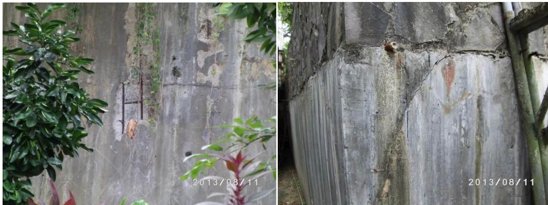
3. 建築物樓版混凝土已大片脫落，且鋼筋已鏽蝕膨脹，已影響結構安全，應即結構補強。
