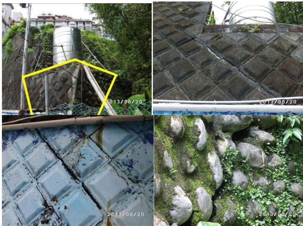
3. 部份擋土牆排水孔水量有夾雜泥砂，應即早改善。附近工地施工已造成局部地表下陷，應請施工承商於相隣之擋土牆加設傾度盤，隨時監測壁體變位。對因地表下陷引起之路面裂縫，應臨時以不透水材料封補阻絕地面水滲入。
