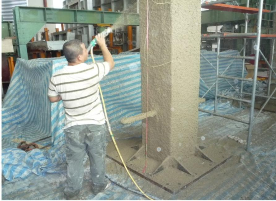
**圖 2.7 噴覆式防火被覆的鋼柱(本研究整理)**
