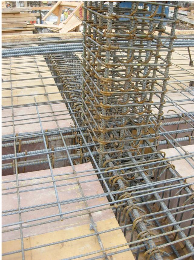
圖 1-7 NIST 之 RC 梁斷面與 RC 柱斷面相同工程實例
