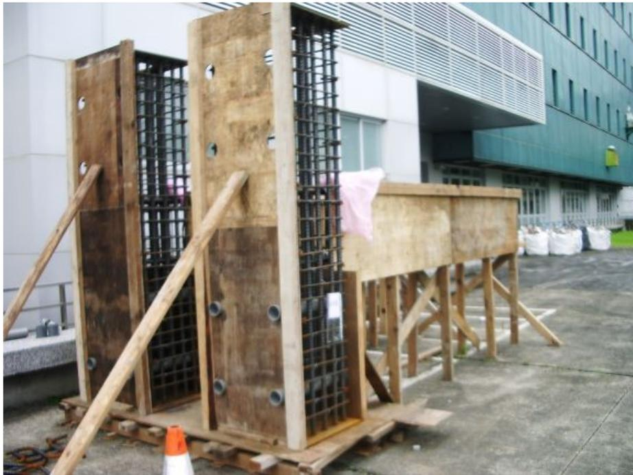
**圖 3-3 試體模板組立圖(柱)**
