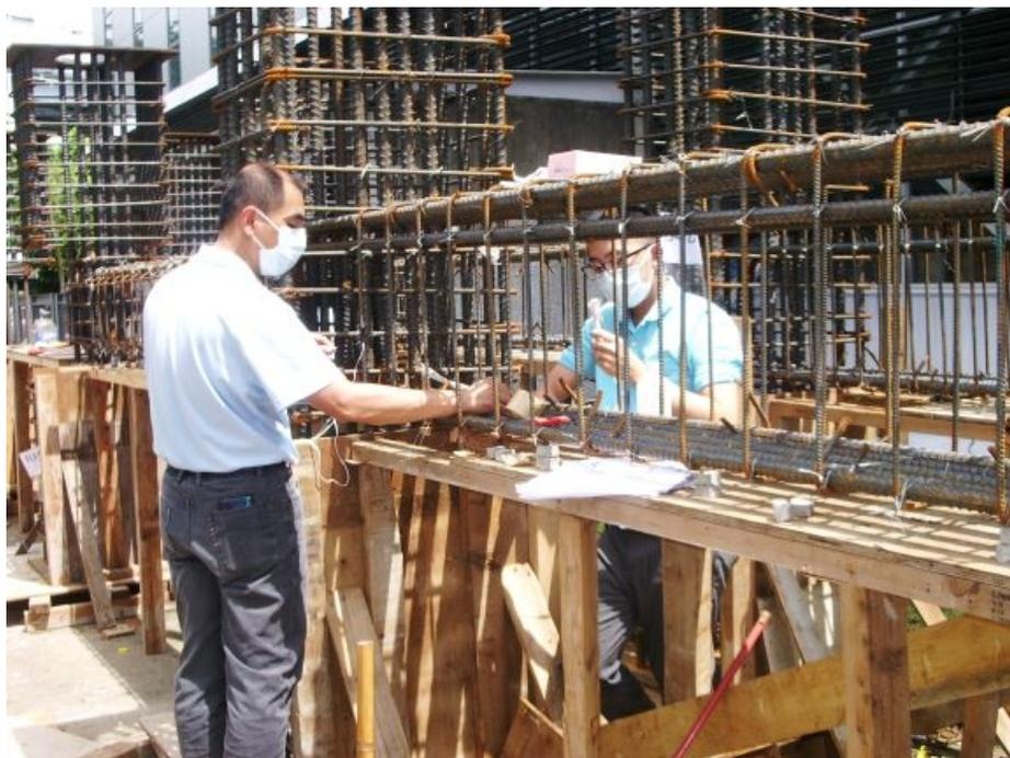
**圖 3-5 試體應變規施工圖(1)**
