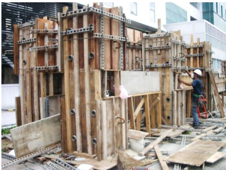
**圖 3-11 試體混凝土澆置完成圖**
