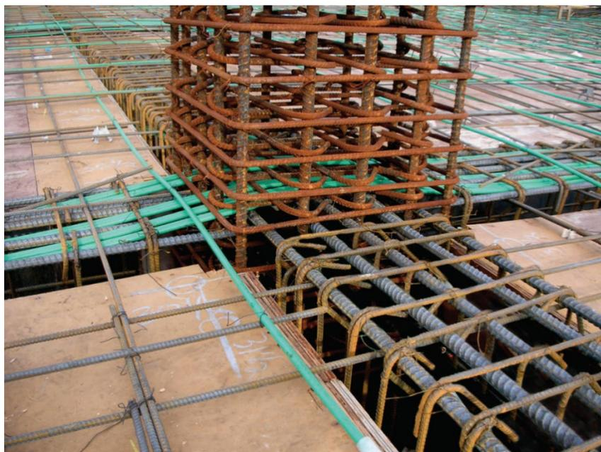
圖 1-6 NIST 之 RC 梁斷面小於 RC 柱斷面工程實例
