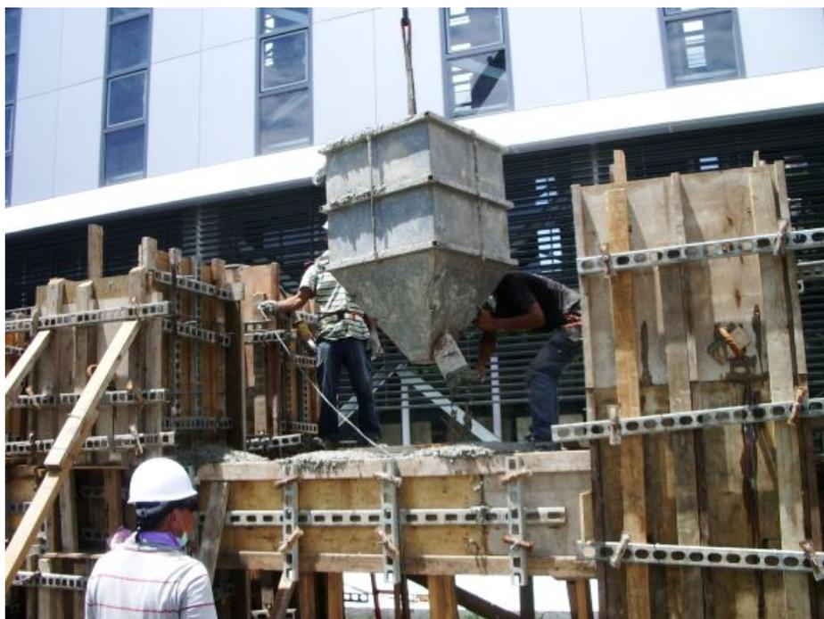
**圖 3-8 試體混凝土澆置圖(2)**
