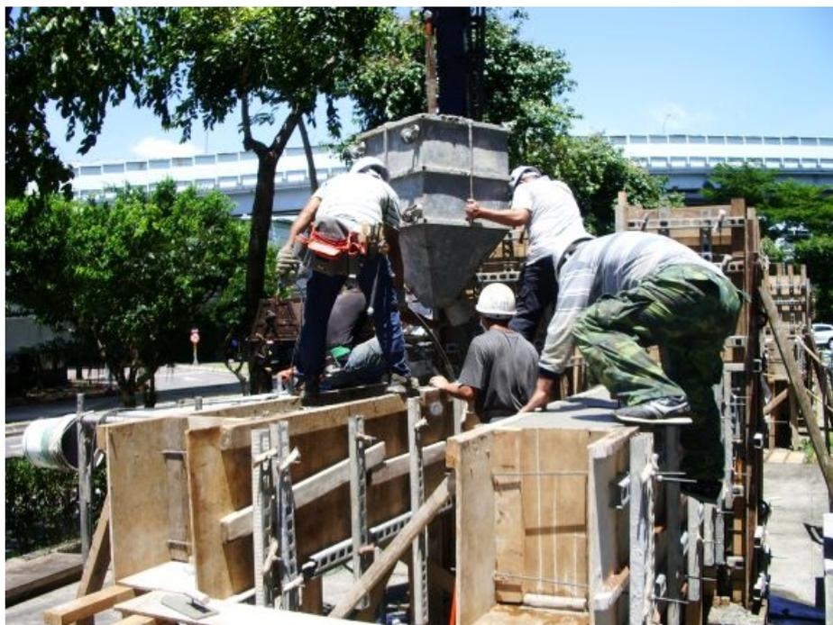
**圖 3-7 試體混凝土澆置圖(1)**
