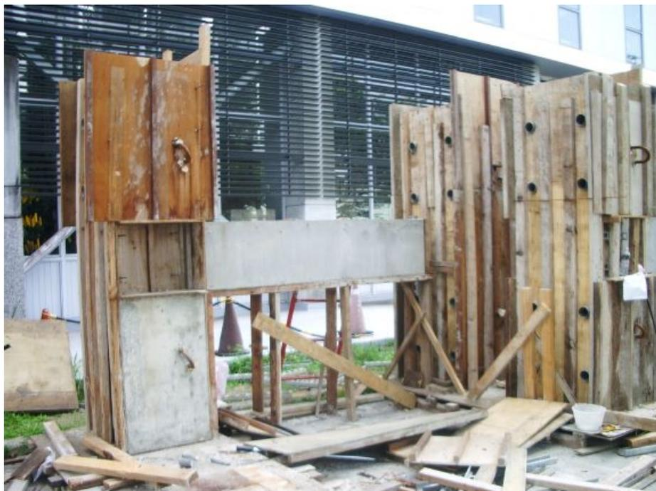
**圖 3-13 試體拆模圖**
