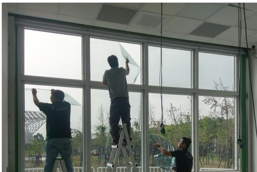
圖 3-3.7 測試 A 室之帷幕玻璃隔熱膜施工
