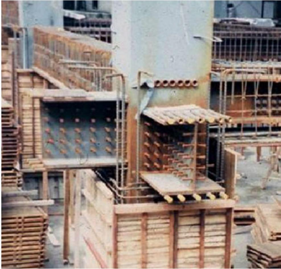
圖 2-3 RC 梁與鋼骨托梁之接合型式[文獻 4]
