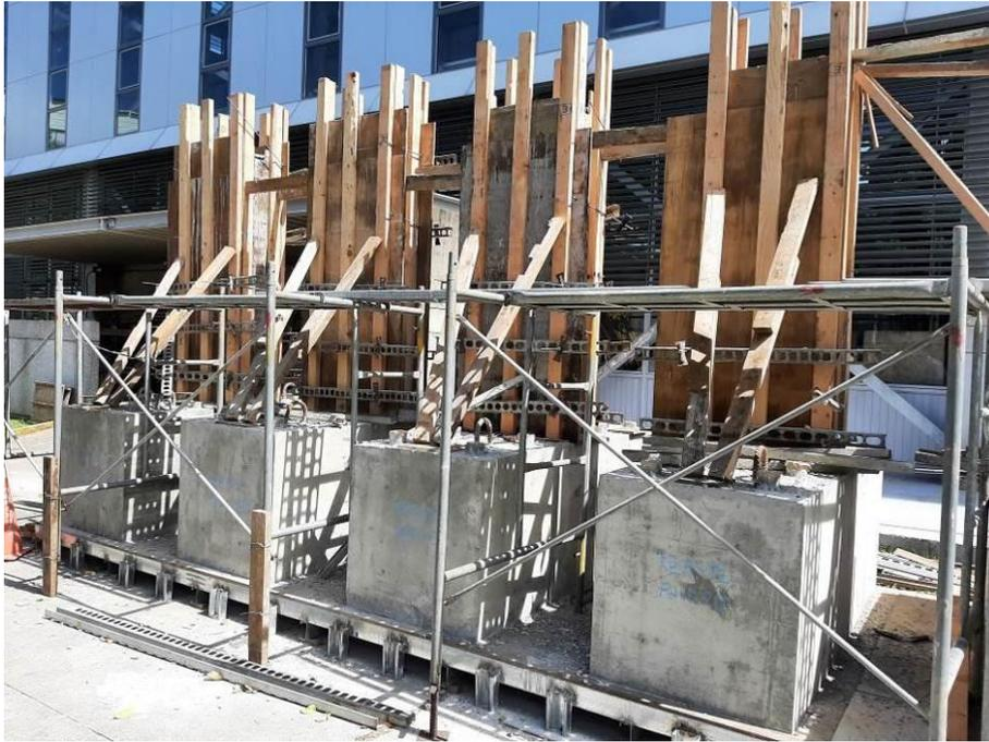
圖 3-8 試體模板組立(柱)
