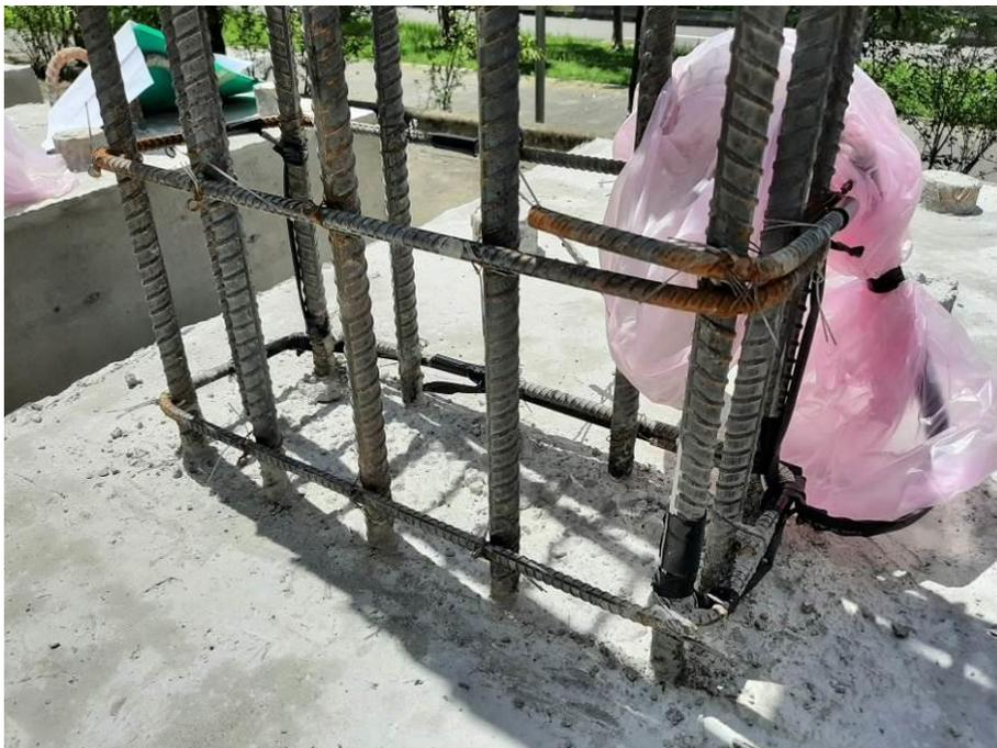
圖 3-7 試體柱內鋼筋黏貼應變計
