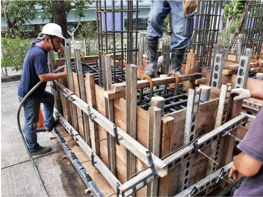
圖 3-6 試體混凝土澆置(基礎)
