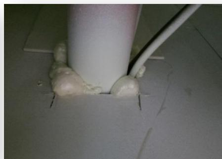
不正確填塞材料及工法
