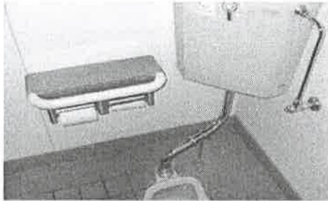
圖4-6 日本三重縣之車站廁所設置加裝水平扶手的雙連式衛生紙架(資料來源：日本三重縣健康福祉部地域福祉室，2007：46)
