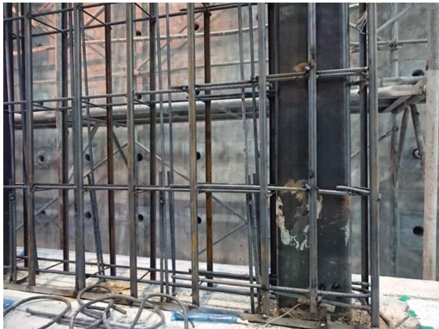
**圖 3.14 鋼網骨架及牆面鋼筋架設**
