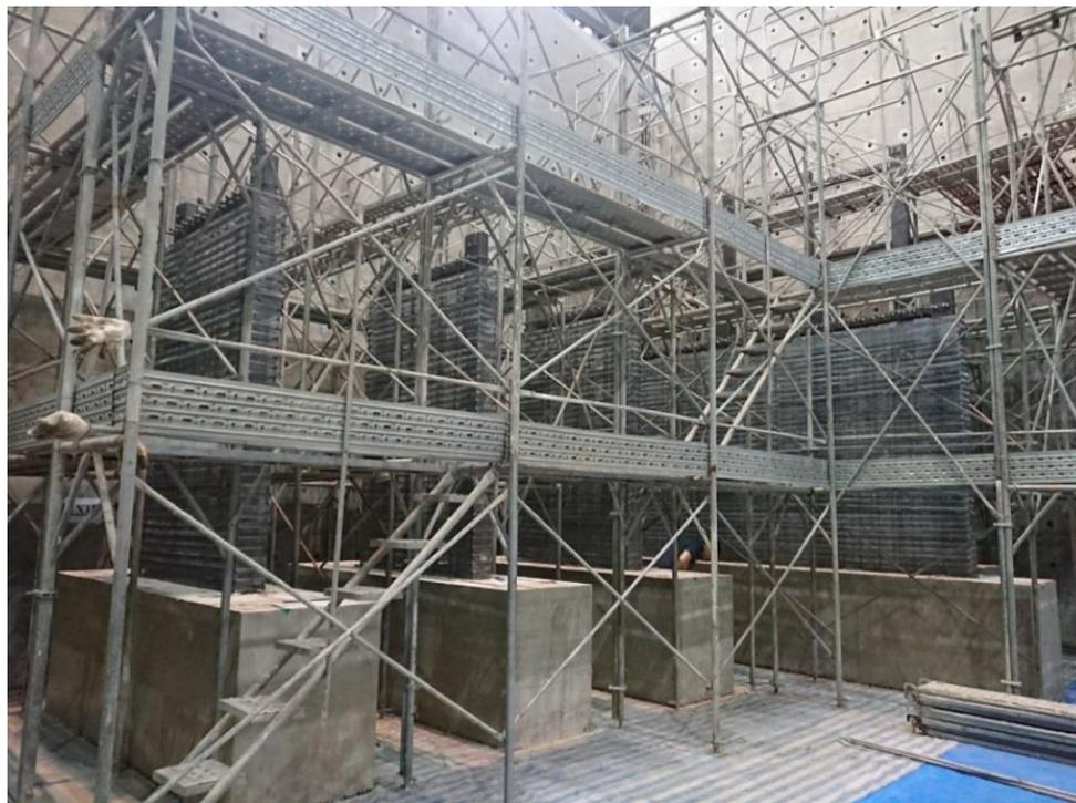
圖 3.16 鋼網牆製作完成
