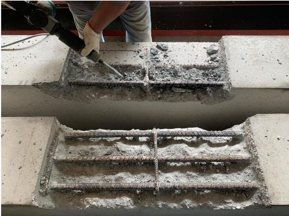
圖 3-31 敲除裂化混凝土及鋼筋腐蝕之受損區域
