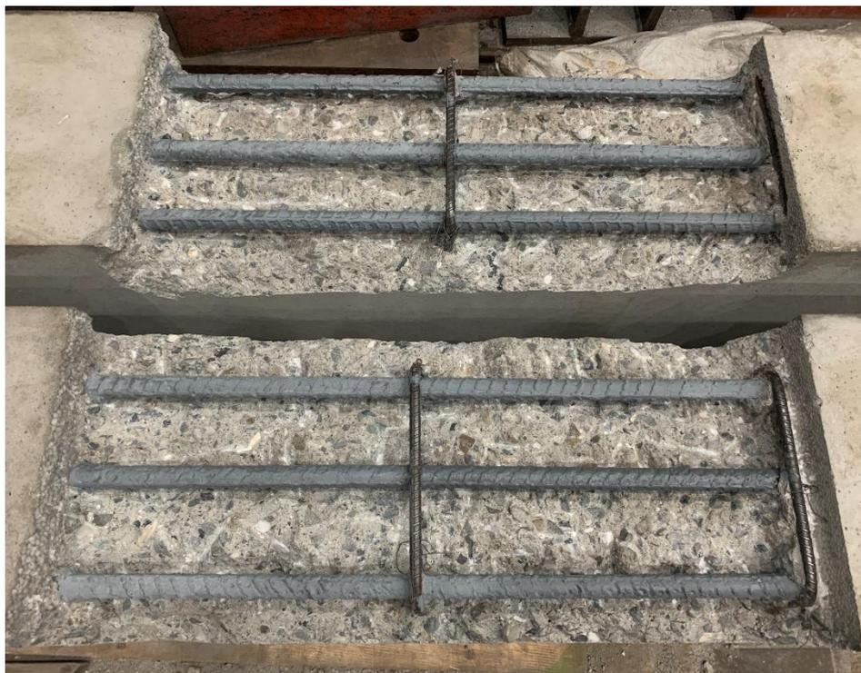
圖 3-34 鋼筋表面塗佈防腐蝕漆
