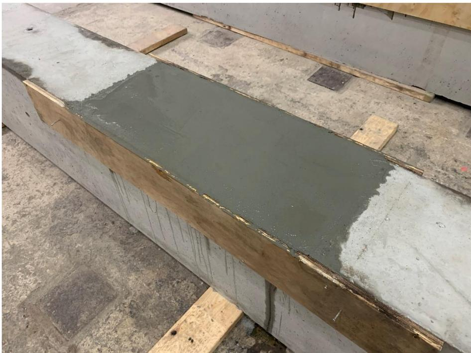
圖 3-39 水泥砂漿修復材完成修復
