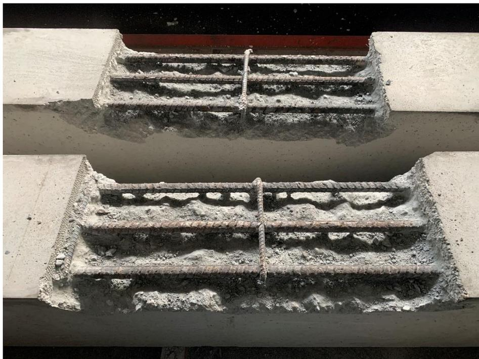
圖 3-32 敲除深度達鋼筋背側
