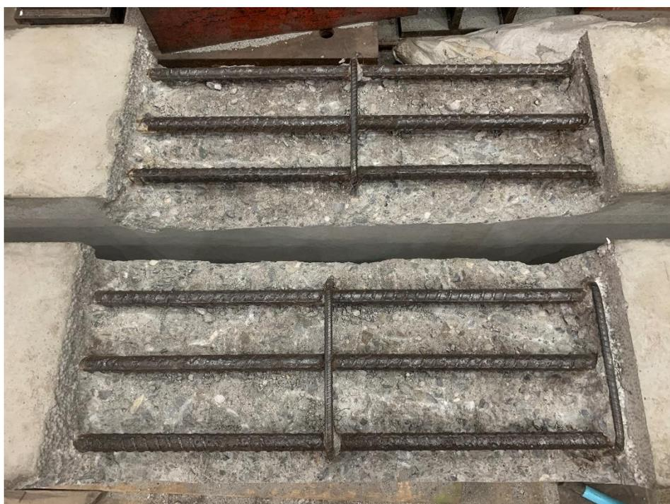
圖 3-33 鋼筋腐蝕清除
