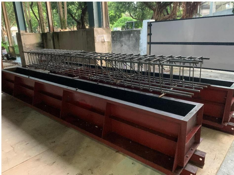
圖 3-27 鋼筋綁紮完成
