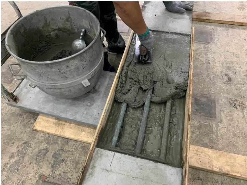
圖 3-37 水泥砂漿修復材灌入
