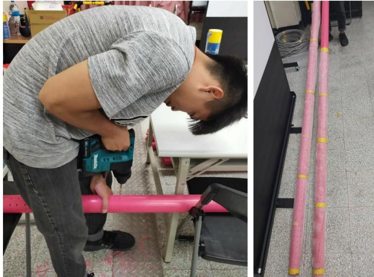
圖 3.2-8 傾斜管於埋設前進行開篩
