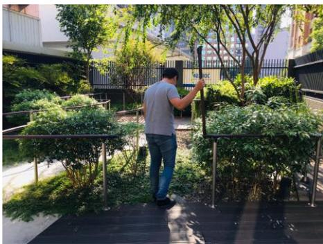
附圖 1 於出入口處通道設置可掀式扶手,以確保扶手機動的連貫性。
