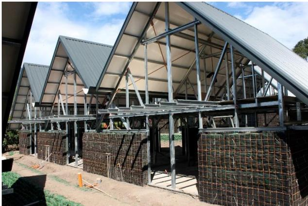
圖 1.5 採以工代賑完成的輕鋼構造八八風災重建永久屋，建議在 CO<sub>2</sub> 減量、廢棄物減量等指標上可被認定為滿分
