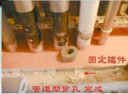
管線與牆體間隙防火填塞(不燃性管線)
