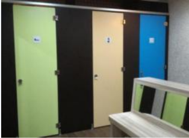
臺北市大安區公所性別友善廁所
