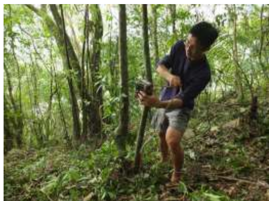
大禮流籠路架設點：山徑旁的小平台
