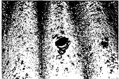
照片 4-6 屋面瓦材 穿孔處漏水缺失實例
