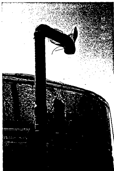
優點：建築物水塔之通氣孔裝設有防蟲網之實例。
