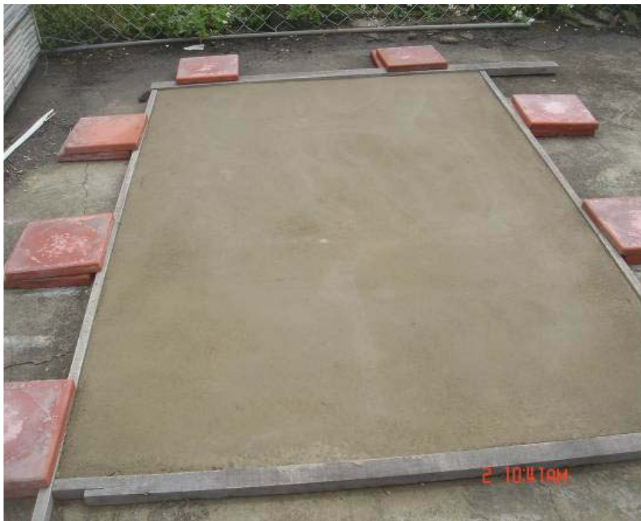
圖3-3 鋪設完成圖 (資料來源：2008,張祖恩、陳文卿)
