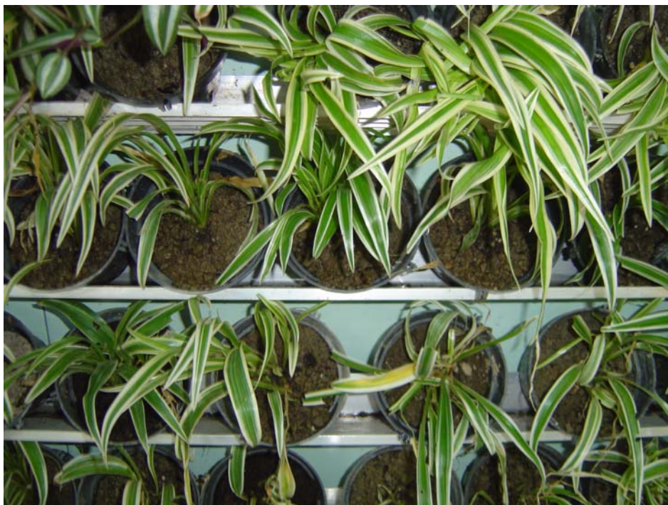
圖 3-45 國立臺灣大學社會科學院新建工程牆面立體綠化
