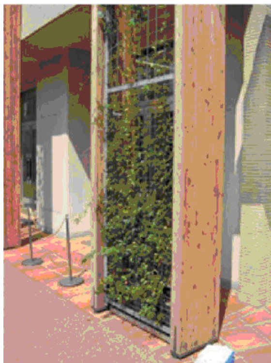
圖 3-9 大乘淑德學園淑德與野國中牆面立體綠化全景
