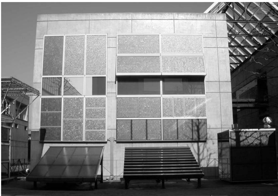
圖 4.39 外牆設置許多建築一體型太陽能光電板
