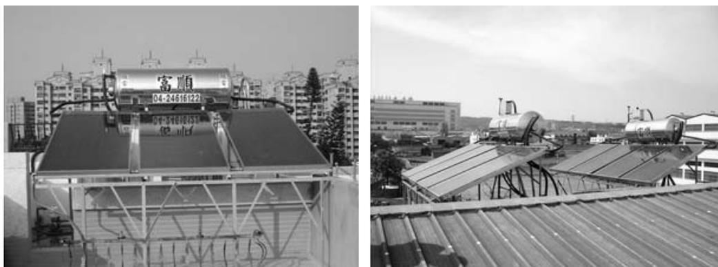
圖 3.6 屋頂高架獨立型太陽能集熱板
