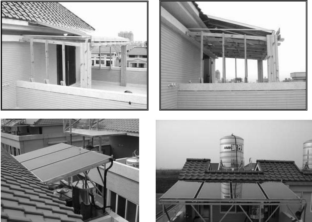
圖 3.4 露台雨庇型太陽能集熱板
