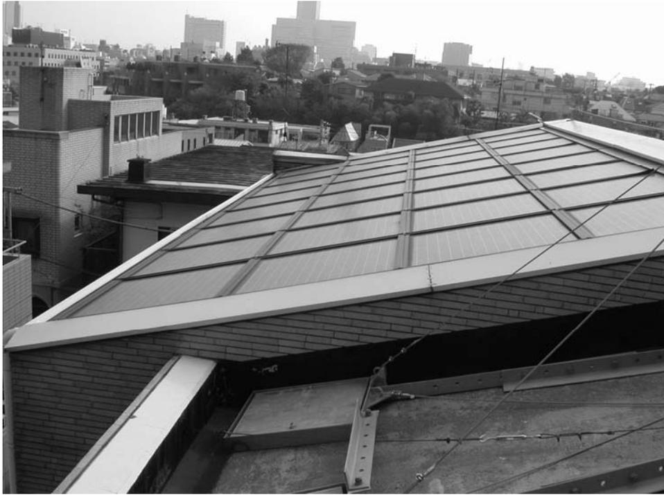
圖 4.26 屋頂裝置與建築一體型太陽能板
