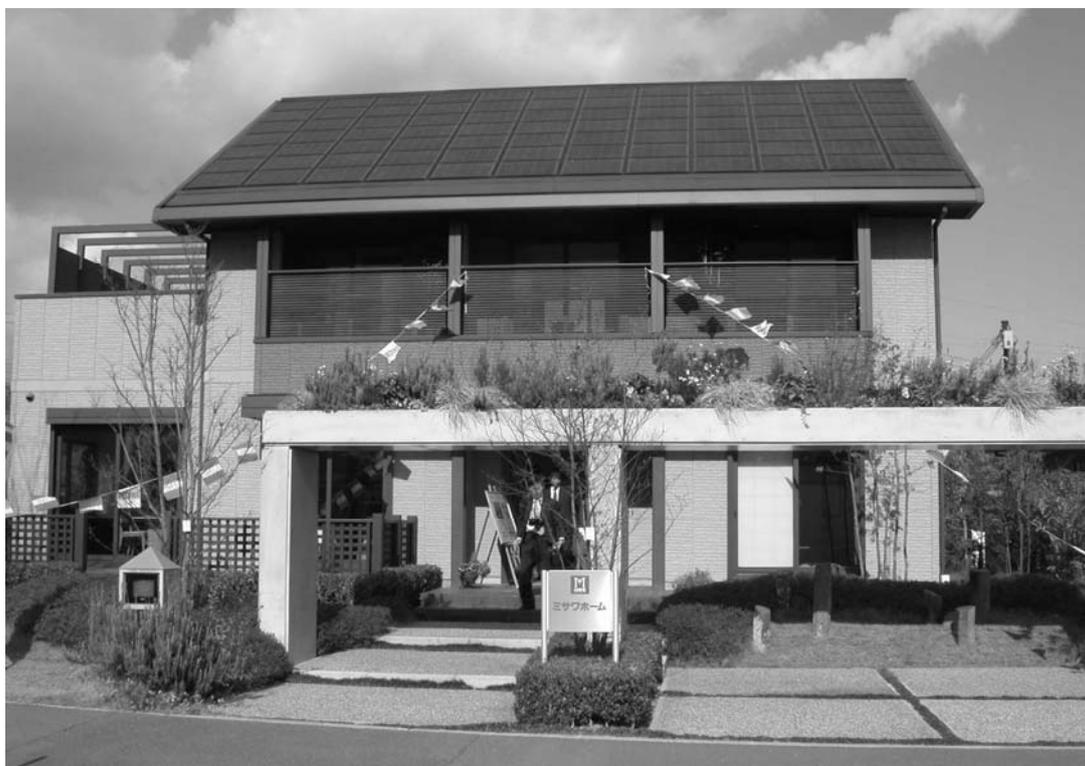
圖 4.32 三澤房屋採用建築一體型太陽能板屋頂
