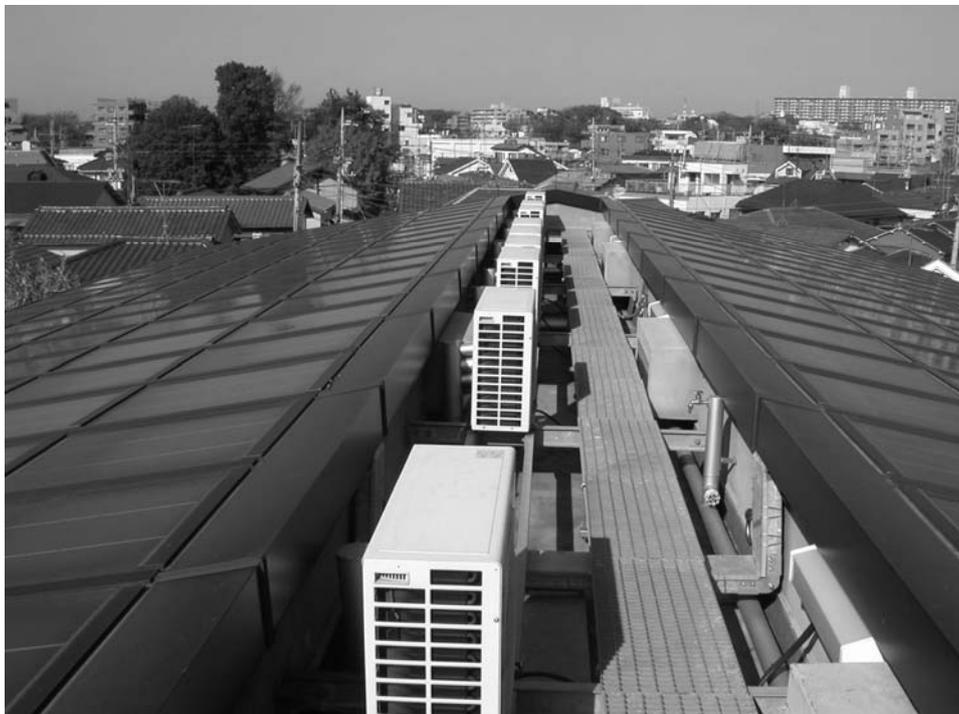
圖 4.33 環境共生單身宿舍屋頂採用建築一體型太陽能發電系統
