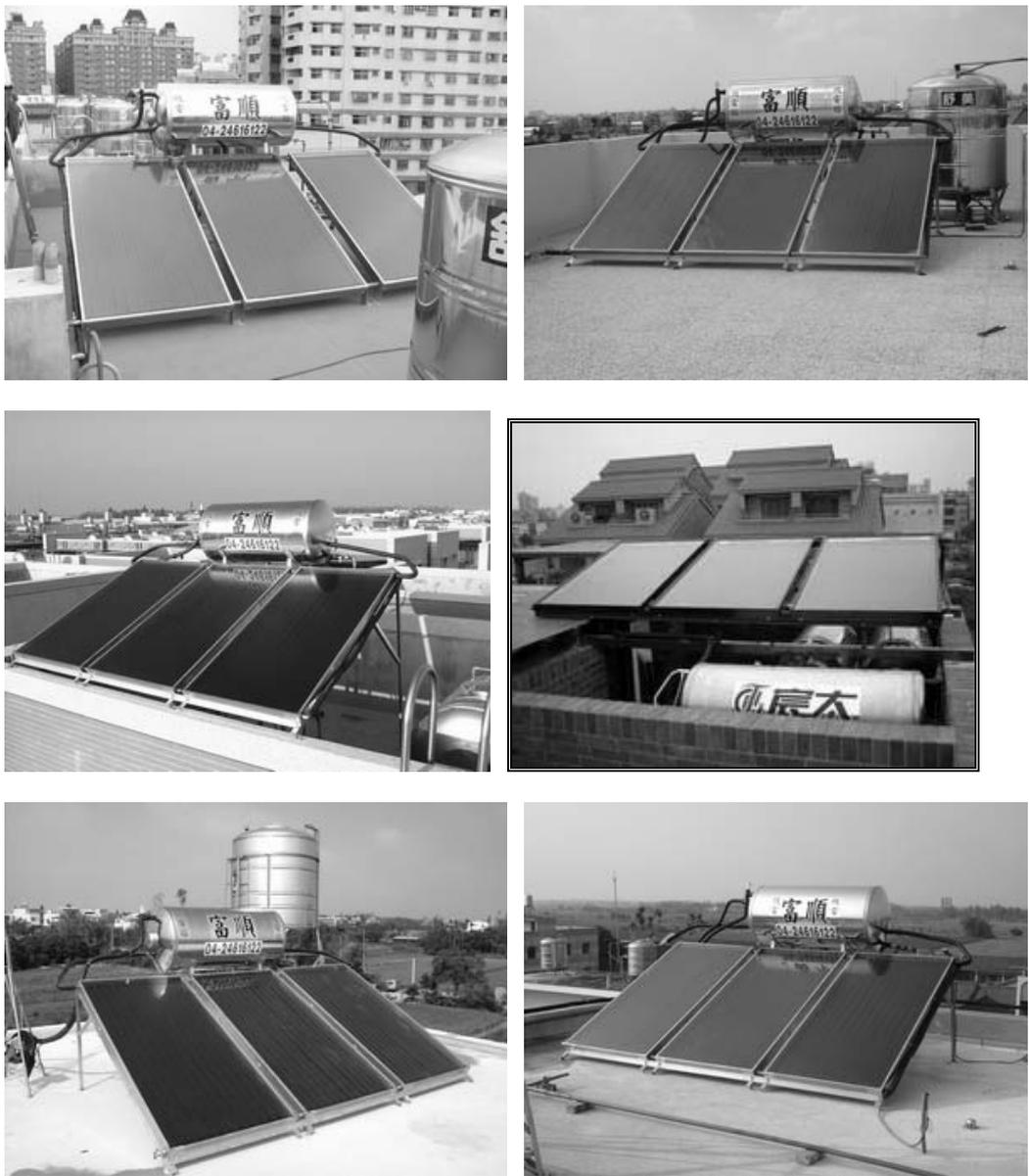
圖 3.7 屋頂平台獨立型太陽能集熱板
