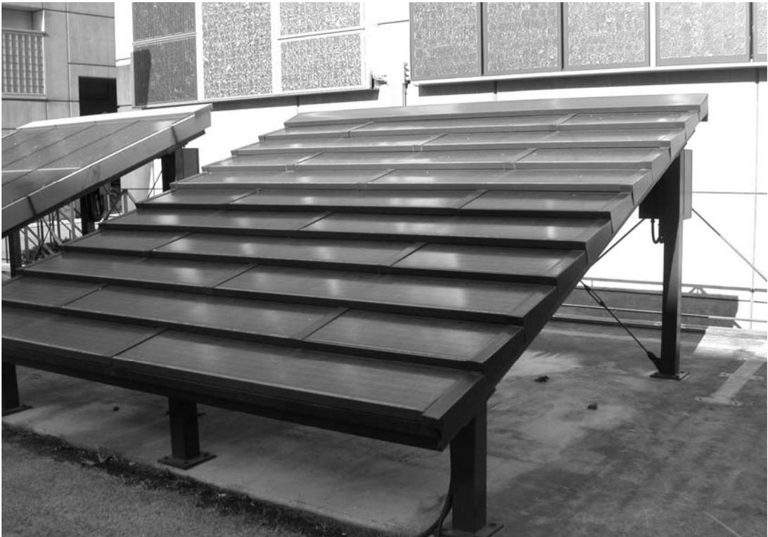
圖 4.41 建築一體型太陽能光電板斜屋頂
