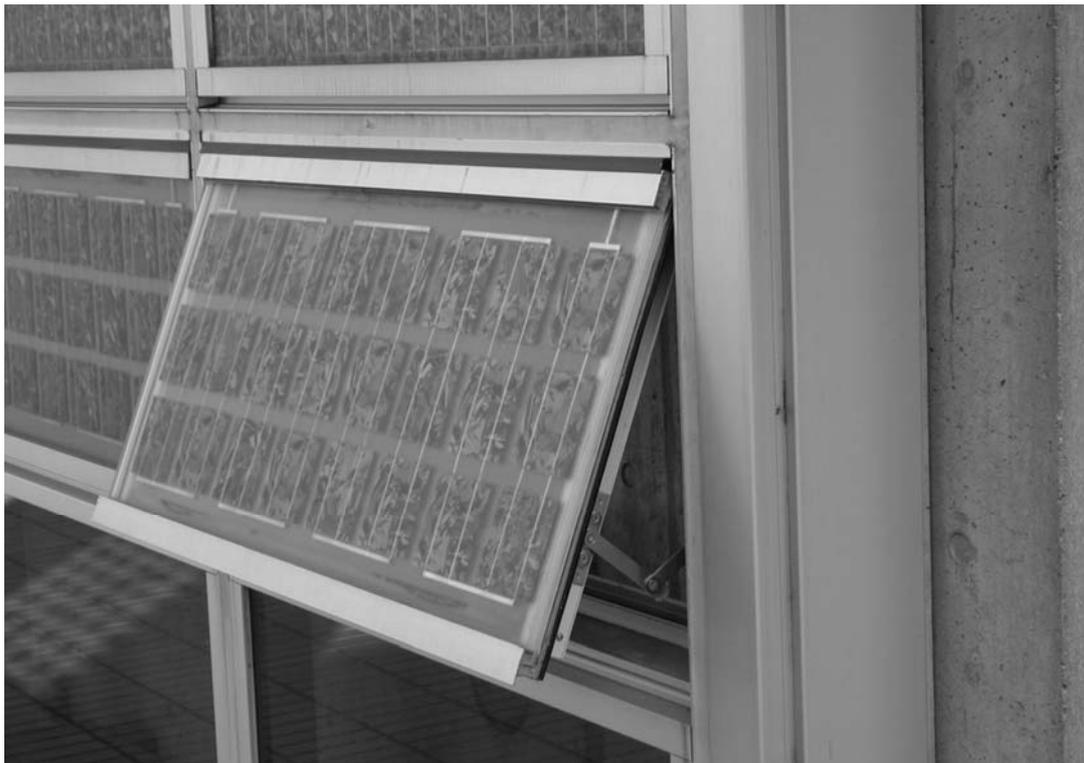
圖 4.38 可開啟之建築一體型太陽能光電板
