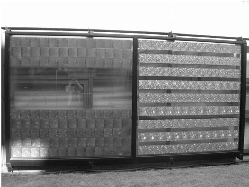
圖 4.35 不同類型的建築一體型太陽能光電板
