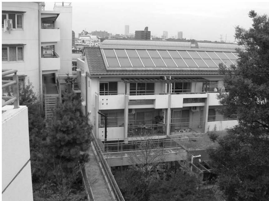
圖 4.24 太陽能集熱器提供行政區樓版暖氣系統與溫水需求
