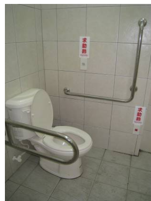
無障礙廁所馬桶按鍵設置於後側
