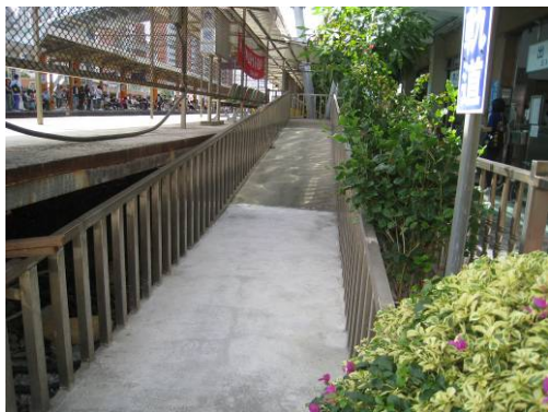
車站大廳平坦通暢，惟地面為光滑石材
