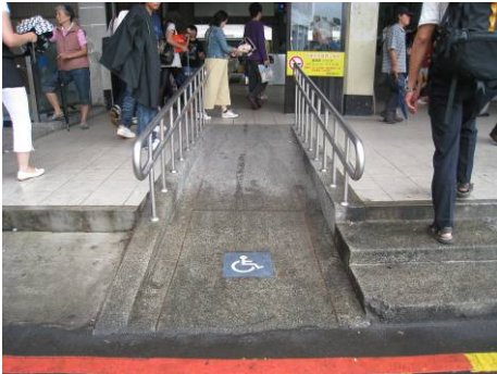
入口高差約 25 公分，設有坡道
