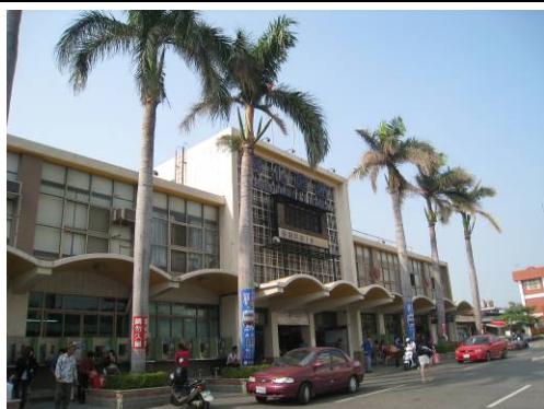
車站入口高差僅約 10 公分入口順平
