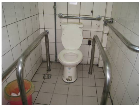
馬桶兩側設固定扶手，輪椅無法進入
