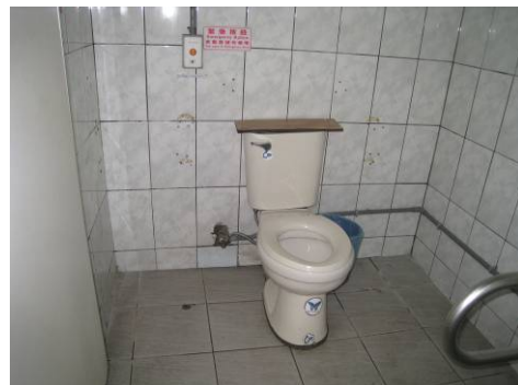
馬桶無扶手，且前面洗面盆扶手擋住通路，不易接近使用
