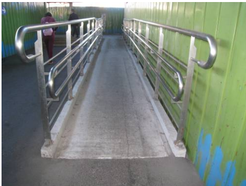
車站入口高差處設有坡道
