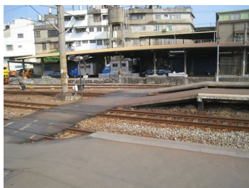
無昇降設備由月台末端斜坡進入月台
