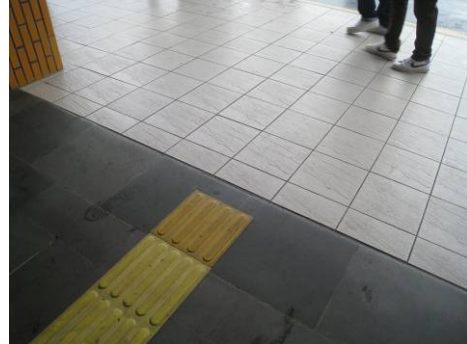
入口平台與車站無高差
