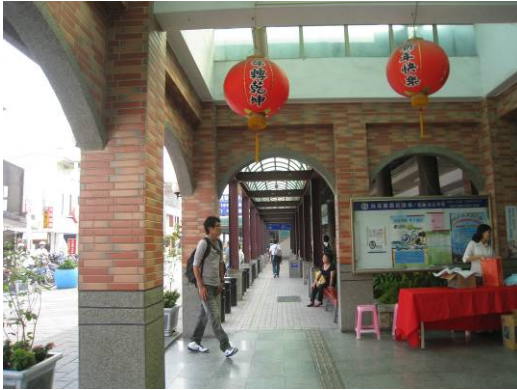
車站入口與路面順平
