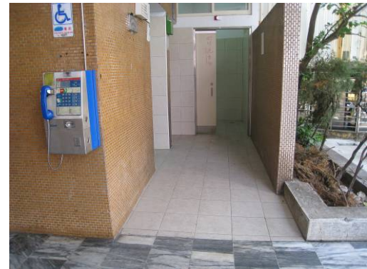
廁所入口無高差且地面材料具防滑性能
