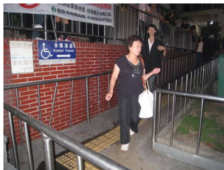
坡道轉彎處缺乏平台
