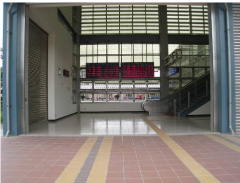
車站入口平坦無高差
