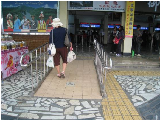
車站入口坡道高差約 60 公分
